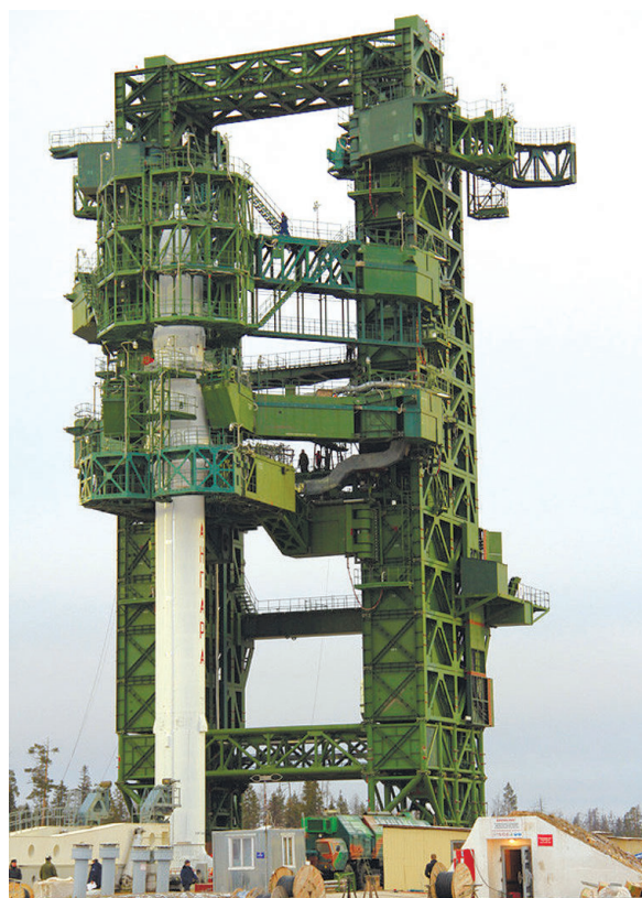
Кабель-заправочная башня космического ракетного комплекса «Ангара» с макетом ракеты-носителя в штатном положении
